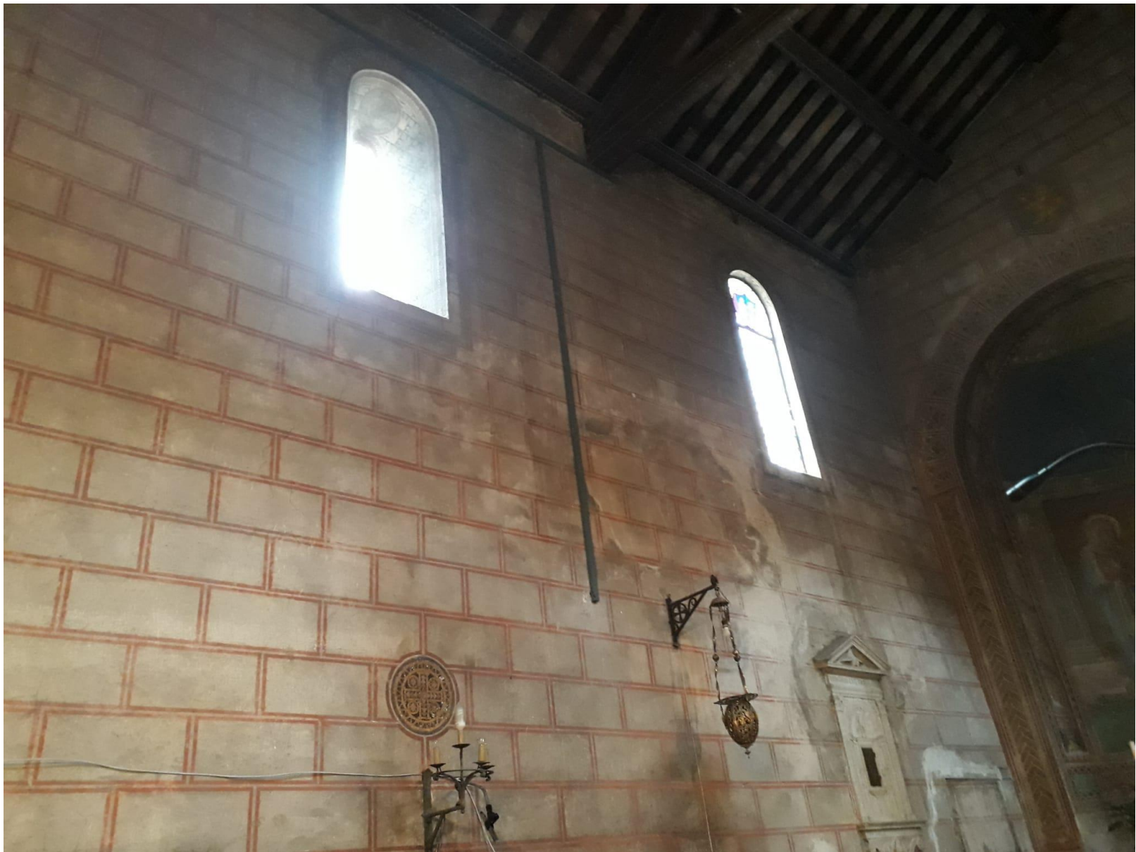
Ferentino, cattedrale, parete laterale sinistra
