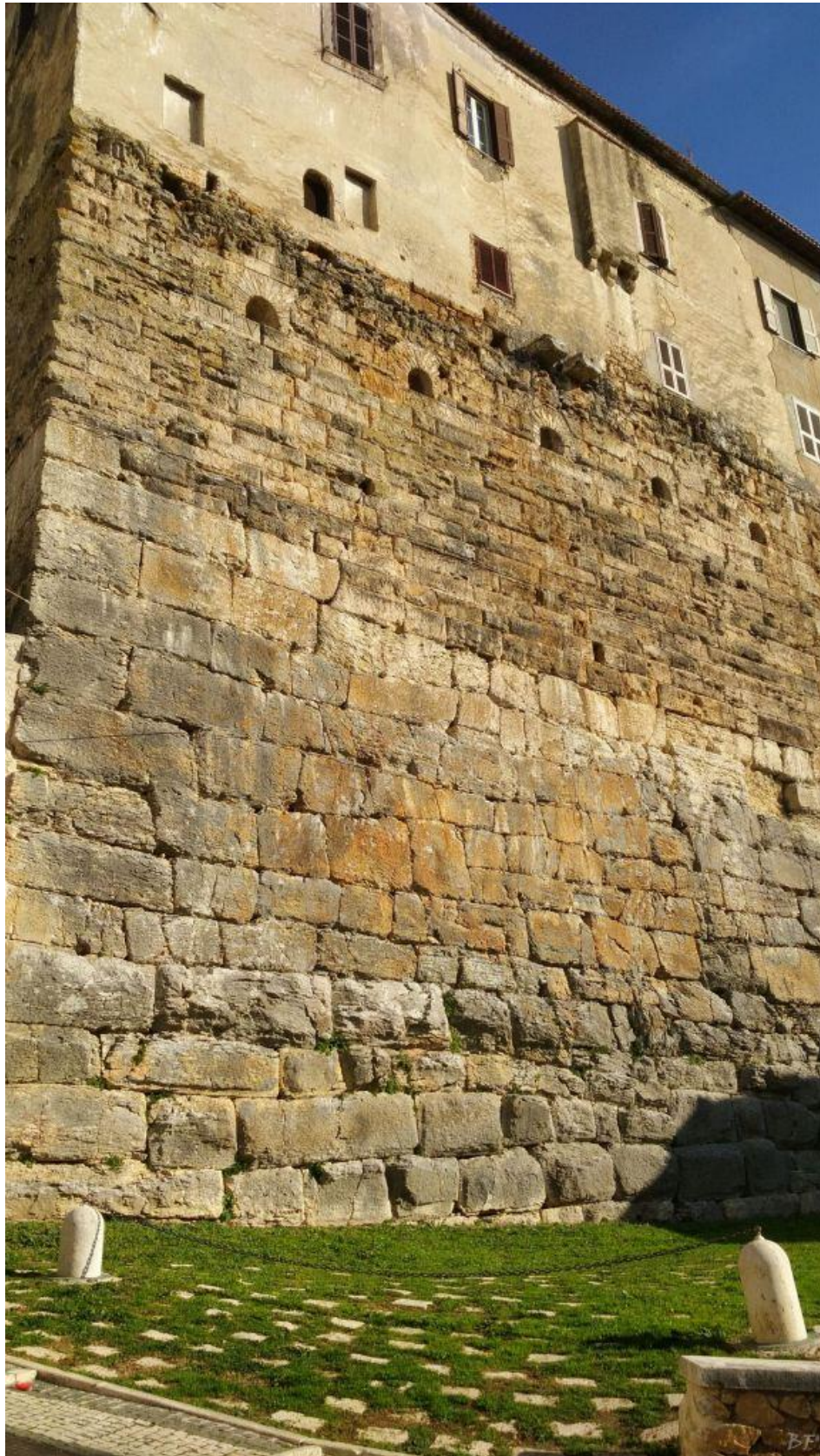
Avancorpo meridionale dell'acropoli romana di Ferentino (II sec. a. C.) Esemplificazione di sistemi costruttivi in opera poligonale
