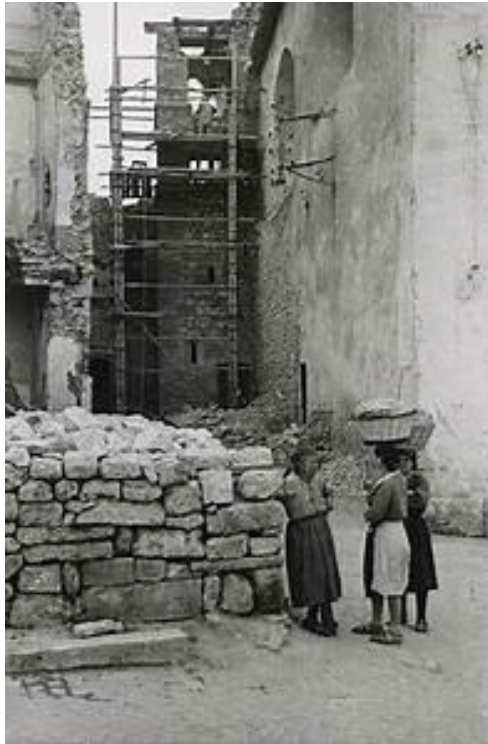
Chiesa di S. Valentino, Campanile, ricostruzione
