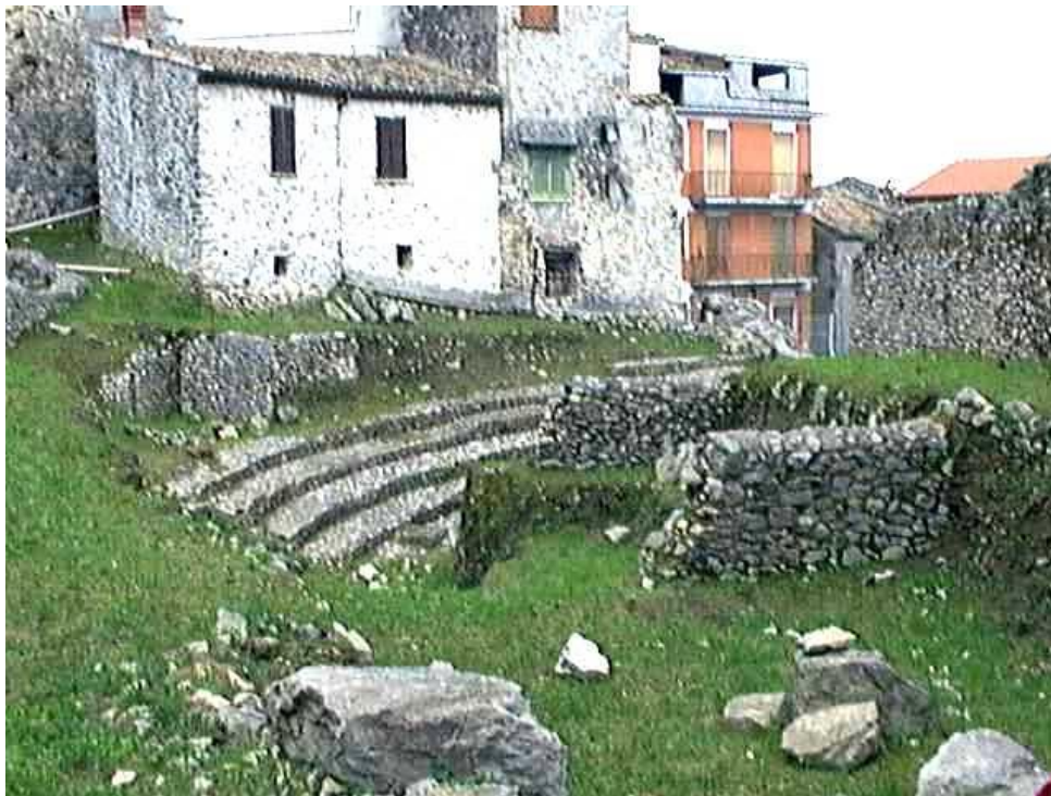
fig. 30 - Ferentino, Teatro romano (sec. I-II d. C.) Veduta delle abitazioni medievali, edificate nel settore orientale della cavea, sfruttando le sostruzioni murarie del teatro romano (foto III media sez. B)
