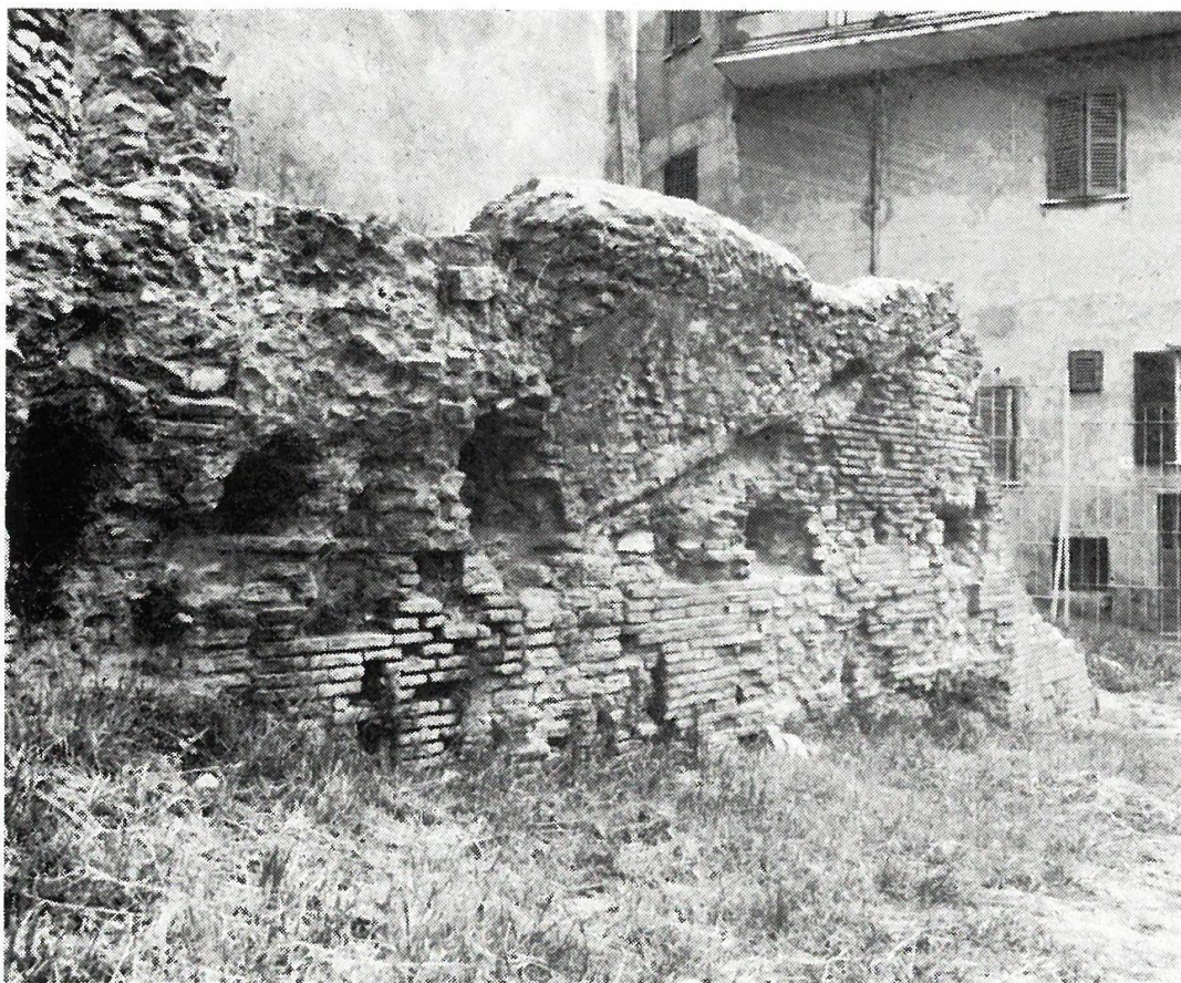
(fig. 8): Traccia della volta inclinata del secondo ordine delle gradinate
