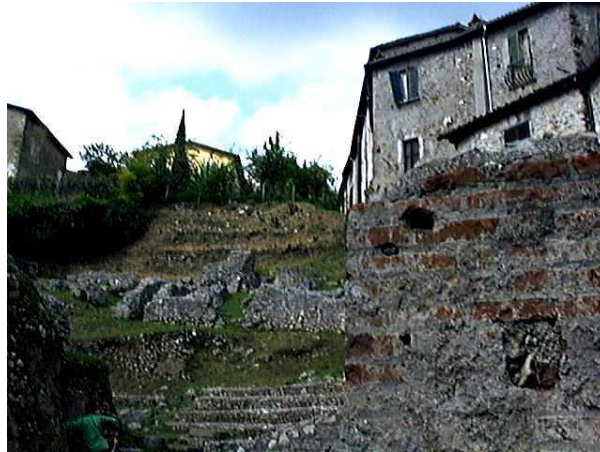
fig. 24 – Ferentino, Teatro Romano, cavea, settore nord-ovest della cavea volta a botte inclinata, sostruzione del secondo ordine di gradinate (foto classe III media sez. B)
