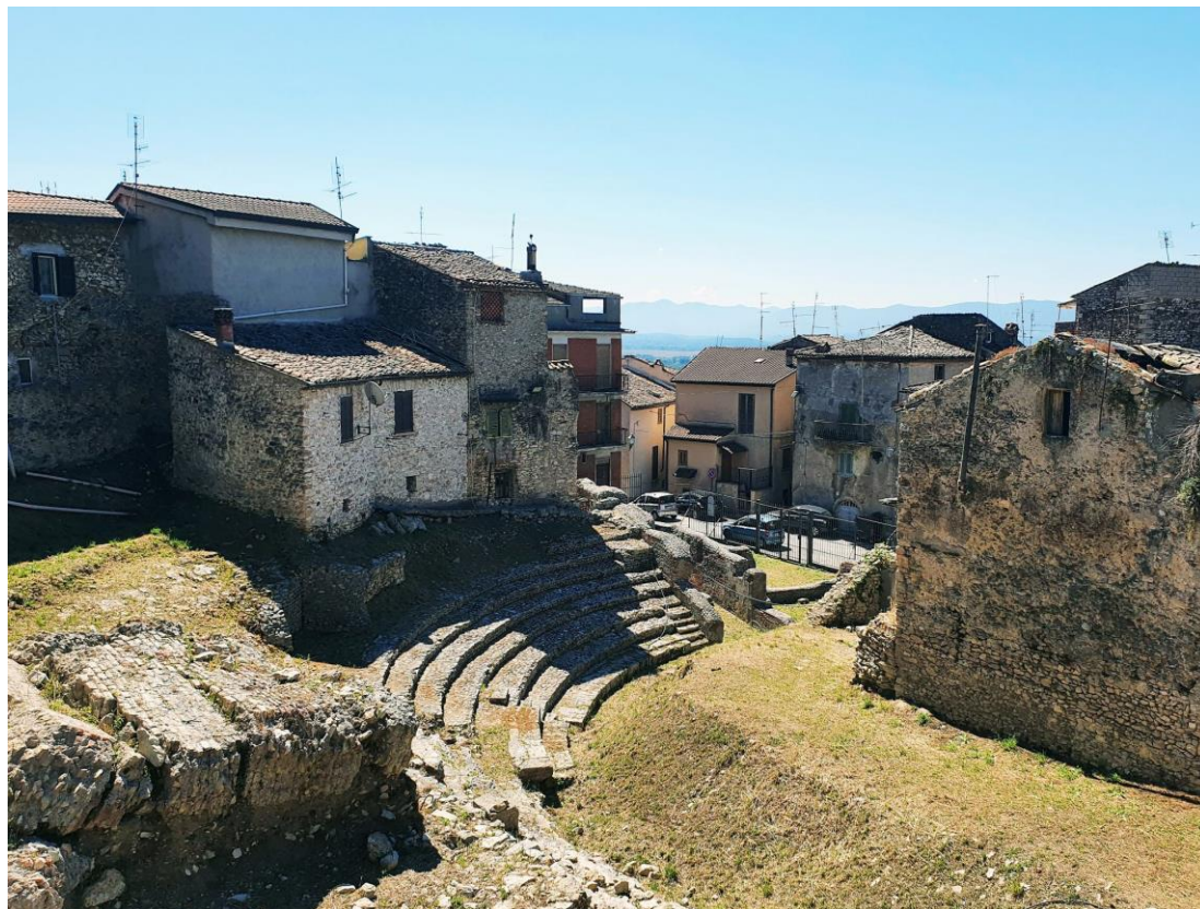
Ferentino, teatro romano, stato dell'edificio agli inizi del 2020 (dal web)
