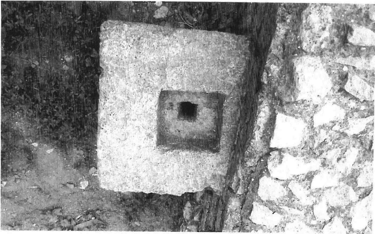
Fig. 10: Particolare della pietra che sorreggeva l'asta del velario.
