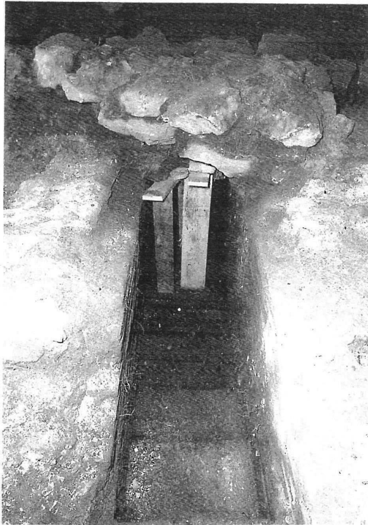
Fig. 11: Fognatura passante sotto la cavea .
