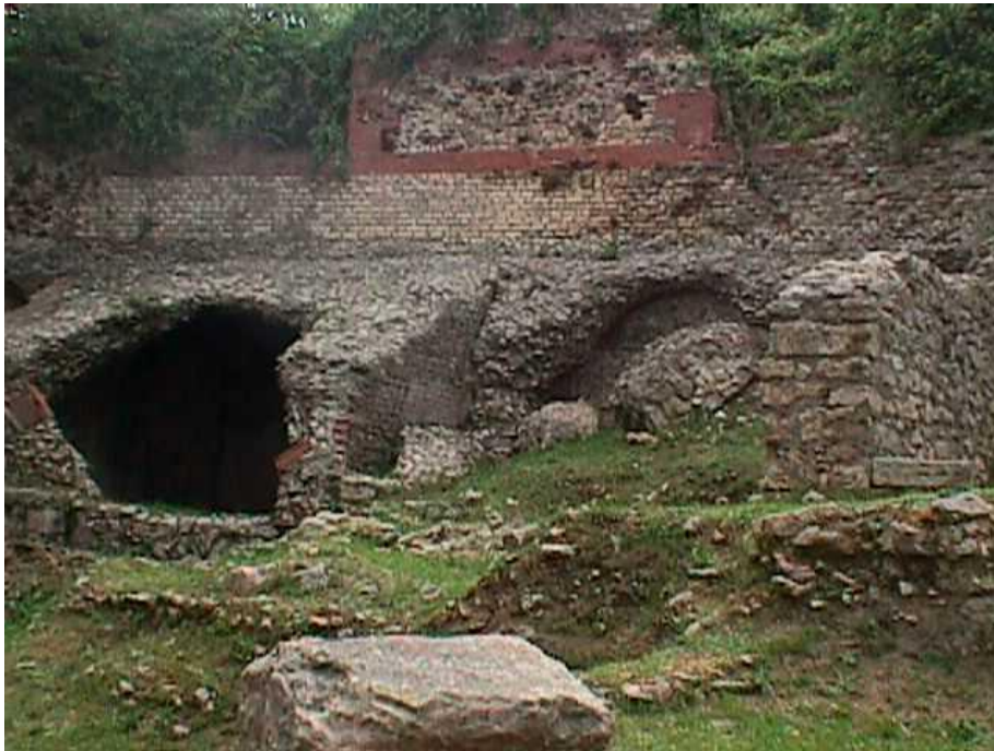
fig. 33a – Ferentino, Teatro romano (sec. I-II d. C.), cavea settore nord-ovest della cavea volta a botte inclinata, sostruzione del secondo ordine di gradinate (foto classe III media sez. B)
