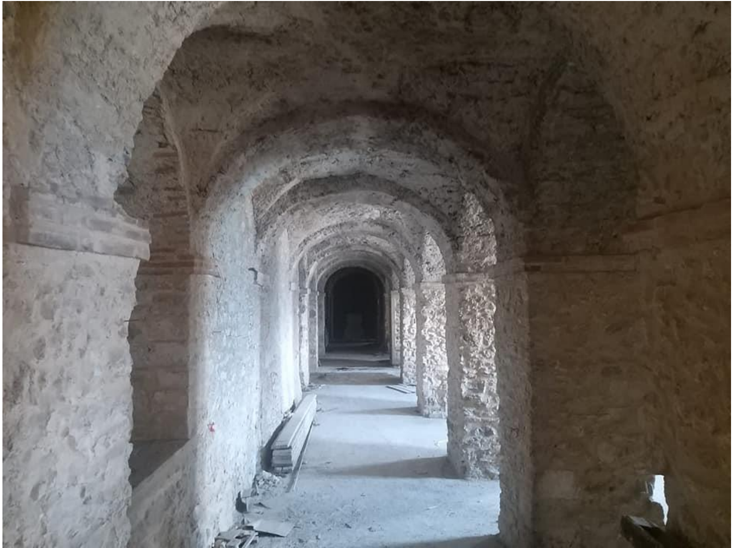
Seminterrato del Palazzo Martino Filetico
