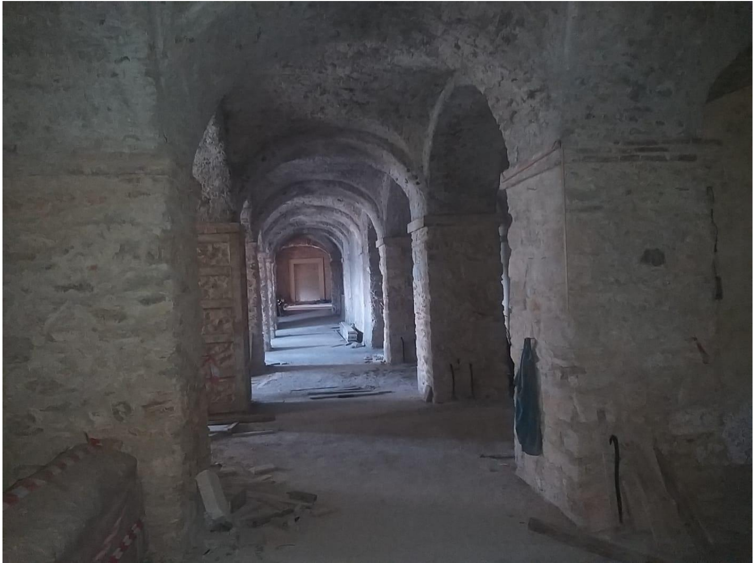
Seminterrato del Palazzo Martino Filetico
